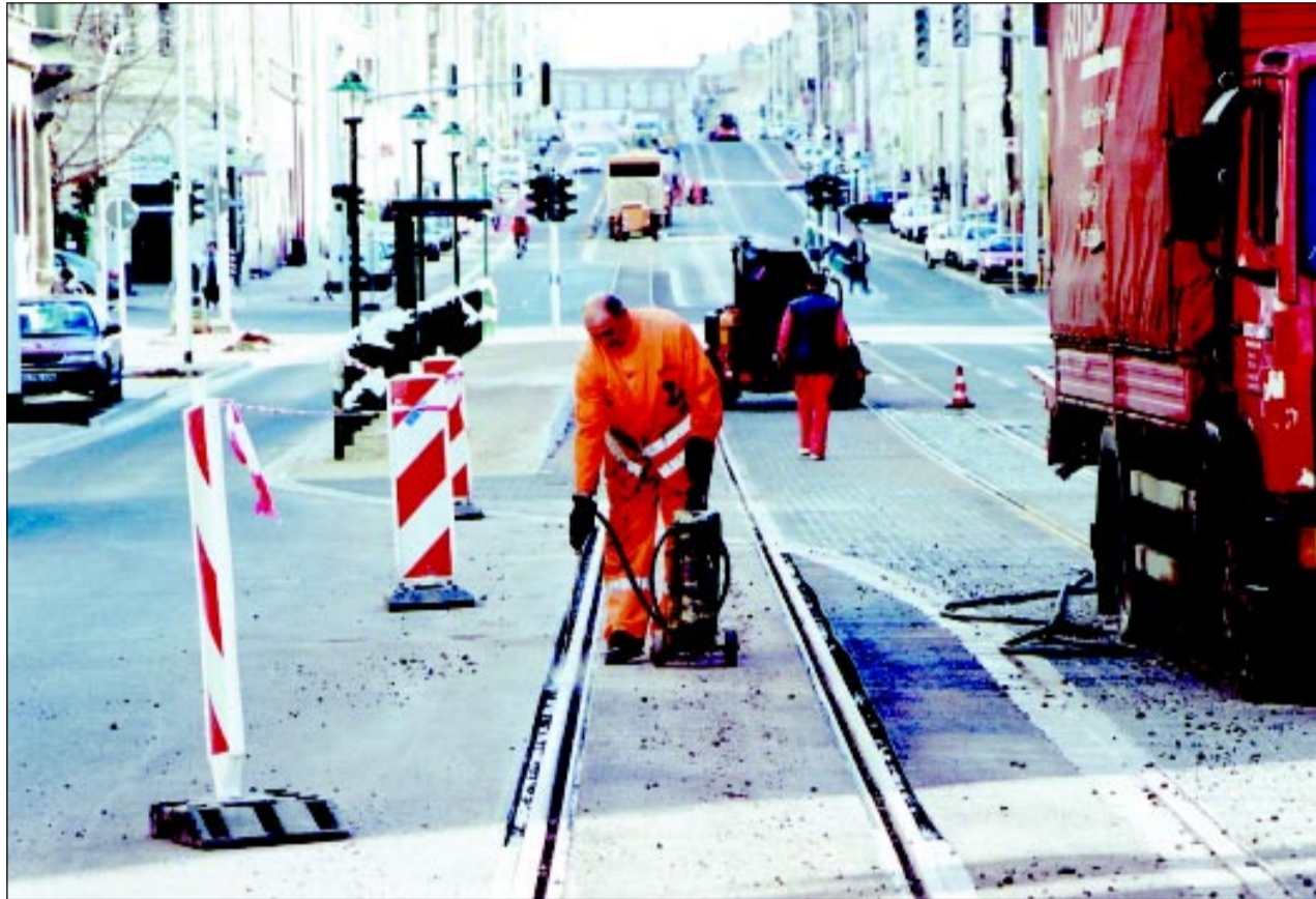
In der vergangenen Woche bestimmten noch die Bauarbeiter das Bild der Ludwig-Wucherer-Straße.
