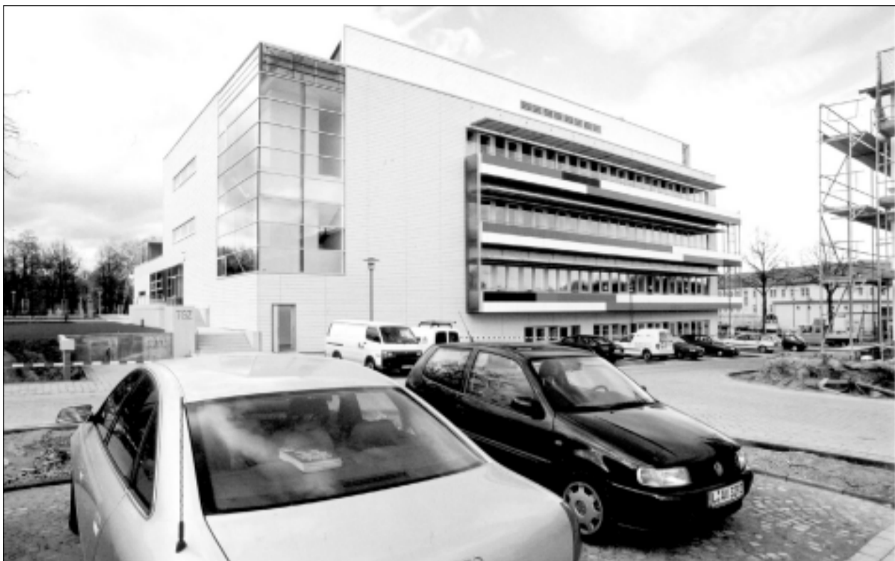
Der Erweiterungsbau des Technologie- und Gründer-Zentrum Halle wurde als Laborgebäude konzipiert. Foto: J. Schlüter
