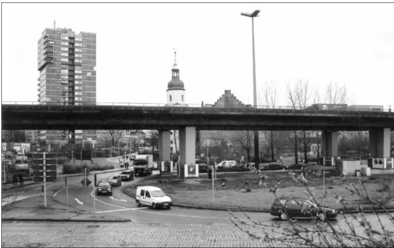
Umfangreiche Bauarbeiten haben auf dem Glauchaer Platz begonnen.
