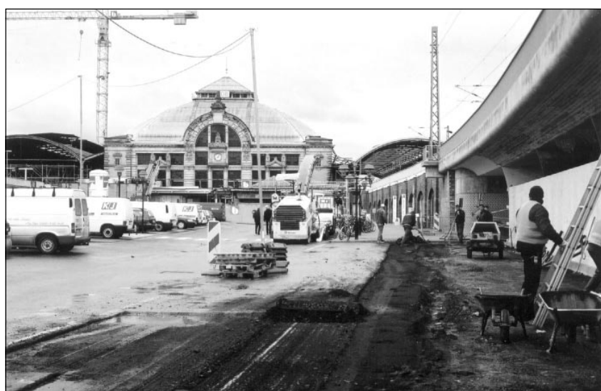
Nach knapp zweieinhalb Jahren wurden am 4. März die Baumaßnahmen an den westlichen Bahnbrücken über die Delitzscher Straße mit Fußgängertunnel und Straßenbahnunterführung abgeschlossen. Tunnel und Bahnübergänge sind nun wieder passierbar. Die Bauarbeiten am Bahnhof gehen weiter.
