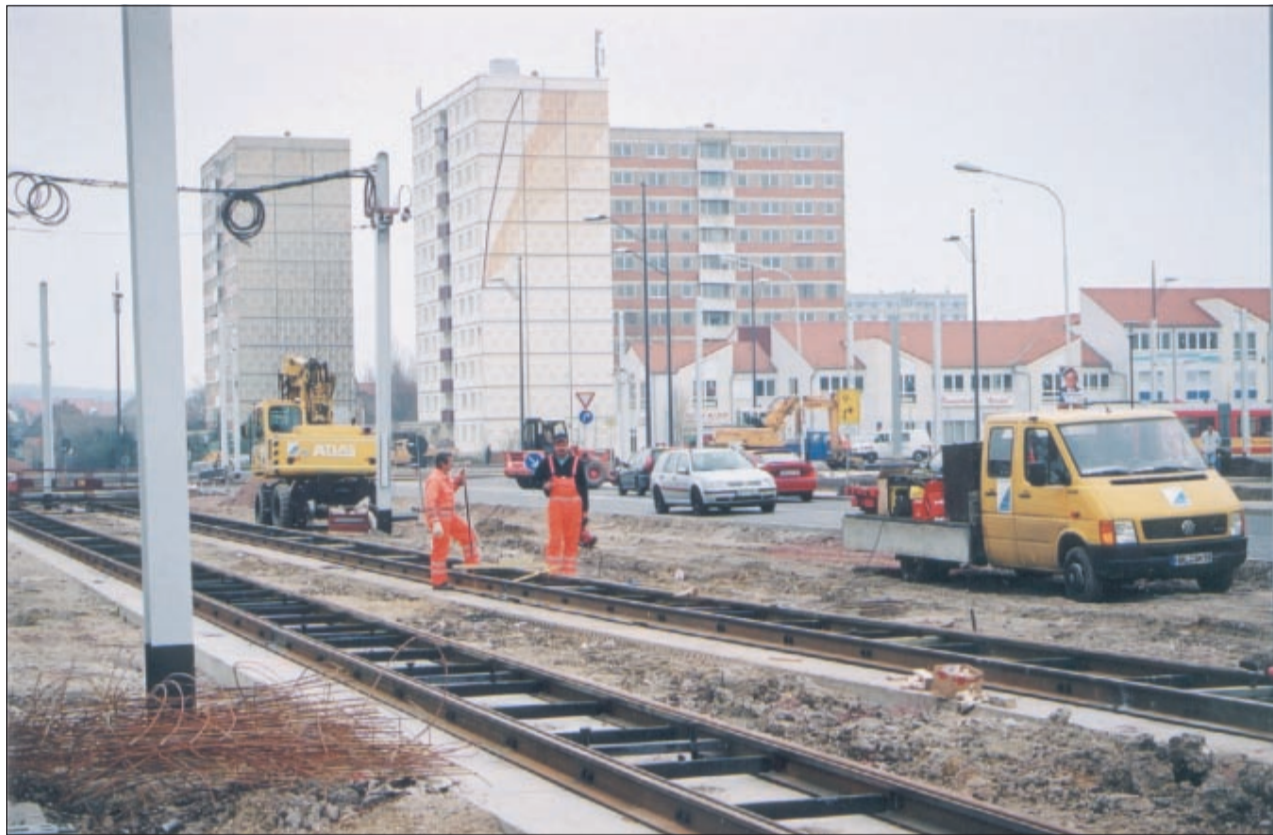
Der Straßenbahnneubau geht weiter. Derzeit wird im Bereich der Weststraße gearbeitet.
