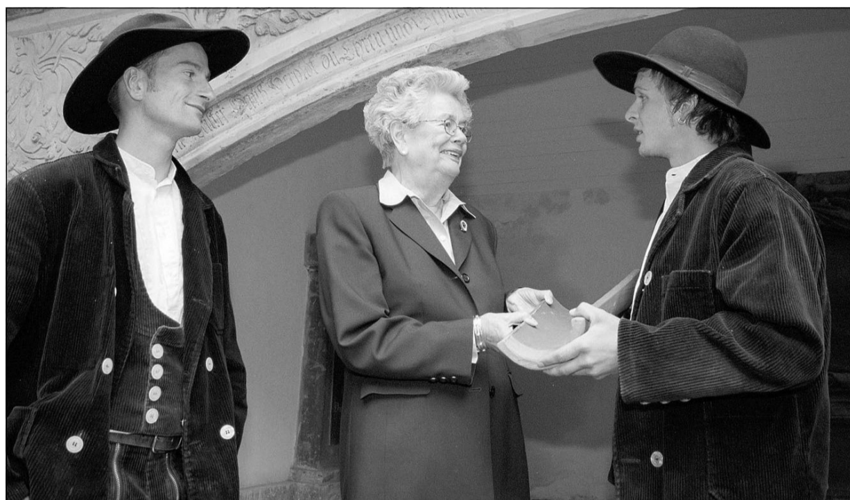
Dr. Marianne Witte, die insgesamt 6,25 Millionen Euro für die Restaurierung des Stadtgottesackers bereitstellt (Amtsblatt berichtet), übergab den beiden Dachdeckern Claus Oppermann und Björn Heßler symbolisch den letzten Firstziegel für die Dacheindeckung der Gruften 42 und 43. Den Abschluss der baulichen Instandsetzung bezeichnete die 80-Jährige als ihr „schönstes Geburtstagsgeschenk“.
