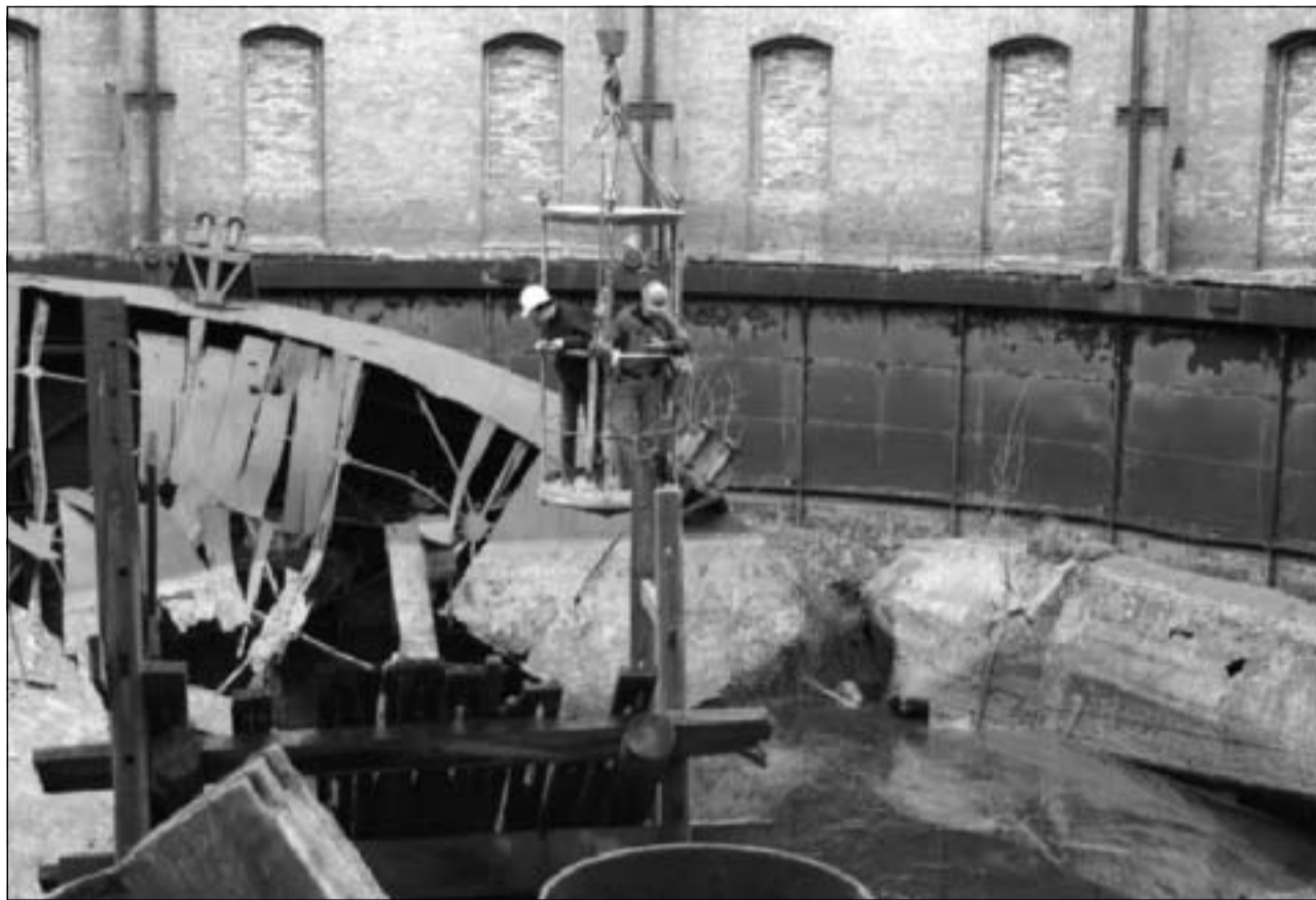
Im Auftrag der Mitgas und des Fachbereiches Umwelt der Stadtverwaltung fanden in diesen Tagen vorbereitende Untersuchungen zur Beräumung des Gasometers auf dem Holzplatz statt. Foto: Th. Ziegler
