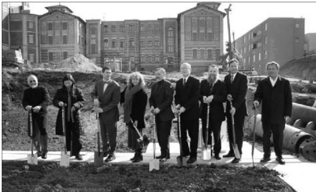
In der Lafontainestraße entstehen neben einem neuen Operations- und Funktionstrakt ein Bettenhaus, moderne Labore, Räume für die Physiotherapie sowie ein neues Foyer. Die Gesamtinvestitionen betragen 25 Millionen Euro, vom Land gefördert.
