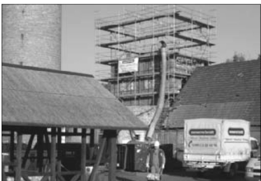
Erstmals seit zwanzig Jahren werden in der Saline substantielle Baumaßnahmen durchgeführt. Zum einen wird die historische Sicheranlage abgebaut mit der Perspektive der späteren Restaurierung. Zum anderen laufen Sicherungsmaßnahmen, die dem Verfall der Grobsiedehalle und des Saalhormmagazins entgegenwirken.
