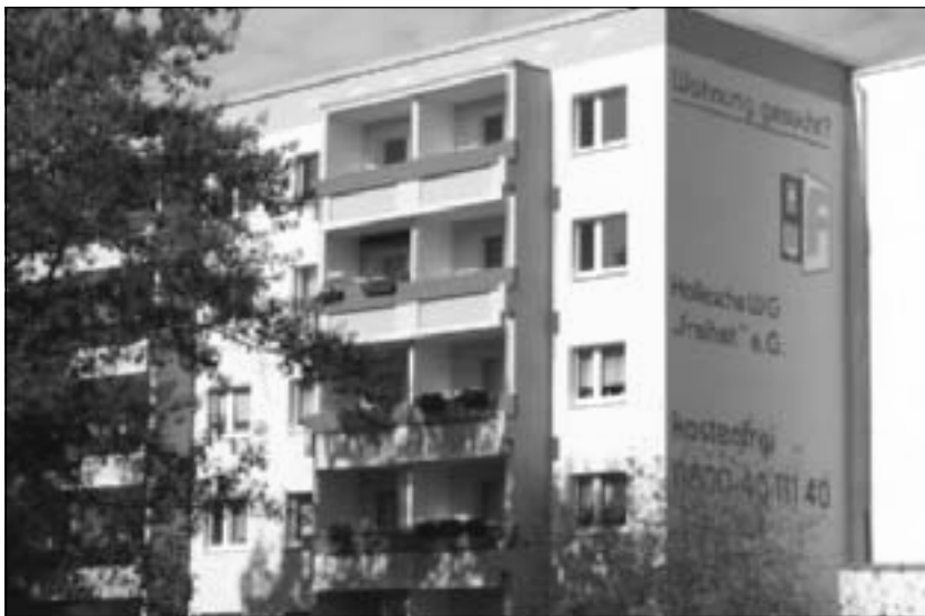
Von der Halleschen Wohnungsgenossenschaft „Freiheit“ e. G. sanierte Wohngebäude am Standort Hirtenstraße/Saalberg. Foto: HWF
