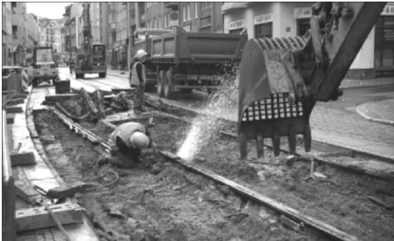
Mit Beginn der umfangreichen Bauarbeiten werden im Steinweg die Straßenbahngleise entfernt.
