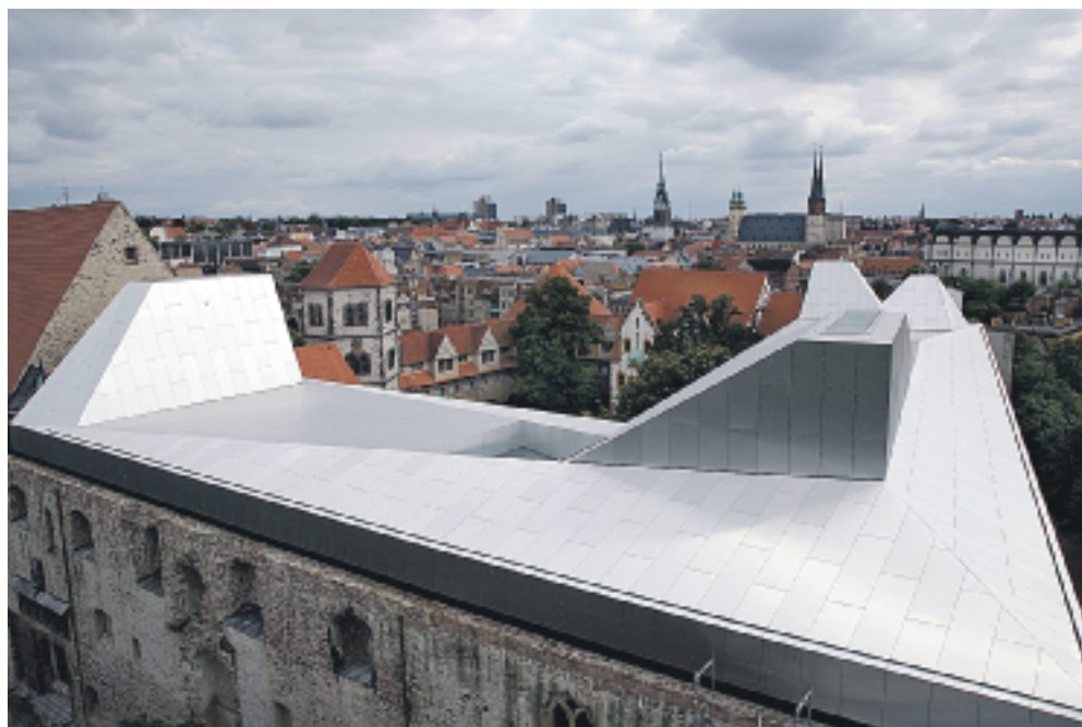
Moritzburg unter neuem Dach
