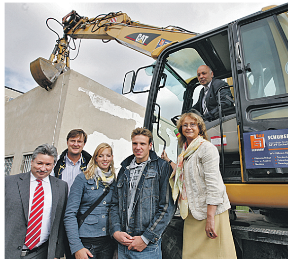
Dagmar Szabados, Paul Biedermann, Daniela Schreiber, Erfolgstrainer Frank Embacher und Peter Kuras, Vizepräsident des Landesverwaltungsamtes (v. r. n. l.) freuen sich, dass der Abriss der maroden Schwimmhalle endlich beginnt. Bürgermeister Dr. Thomas Pohlack (im Bagger) gibt das Startsignal. Foto: Th. Ziegler
