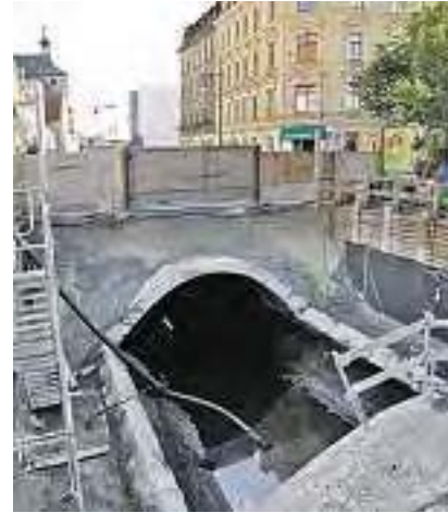
Komplizierte Verhältnisse: Baugrund und Grundwasser verzögern die Bauarbeiten im Bereich der Gerbersaale. Foto: Thomas Ziegler
