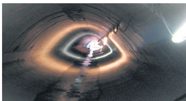
Nach Abschluss der Arbeiten kann sich die Gerbersaale in ein komplett neues Betonbett legen.
