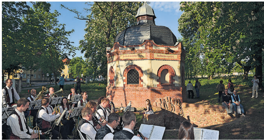
Dank des bürgerschaftlichen, ehrenamtlichen Engagements ist das Brunnenhaus wieder zu einem architektonischen Kleinod geworden. Foto: Thomas Ziegler
