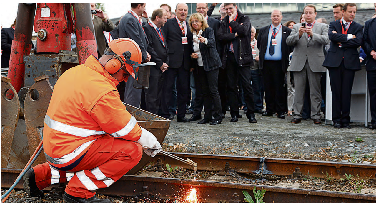
Kein Spatenstich, sondern per Schweißgerät geht es den alten Schienensträngen an den Kragen. Jetzt begannen am halleschen Hauptbahnhof die Ausbauarbeiten für eine der modernsten Zugbildungsanlagen Europas. Foto: Thomas Ziegler
