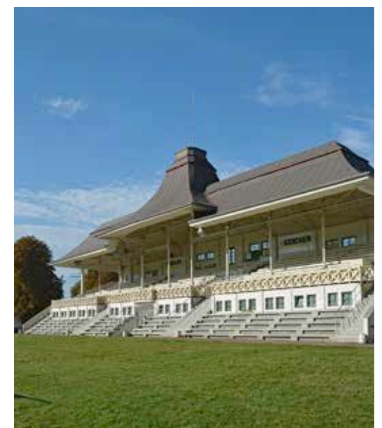
So sieht die Anlage heute aus. Die Räume im Untergeschoss der Tribüne sollen bald wieder geöffnet werden. Foto: Thomas Ziegler
