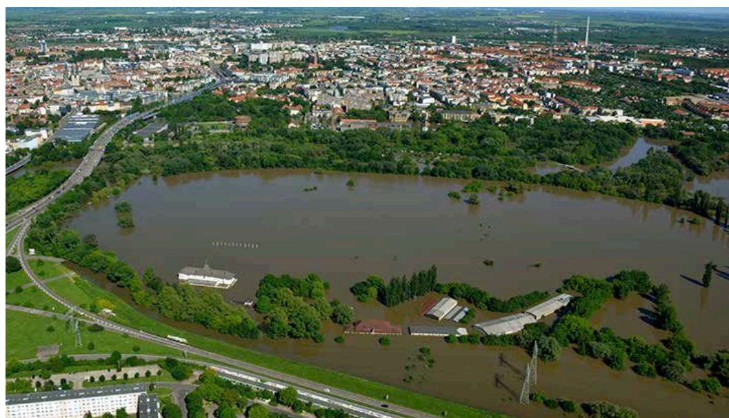
Immer wieder steht das Gelände am Passendorfer Damm unter Wasser. Die Aufnahme stammt aus diesem Jahr. Die Pferde konnten rechtzeitig in Sicherheit gebracht werden. Der Schaden an den Rennbahnanlagen war immens. Foto: Horst Fechner
