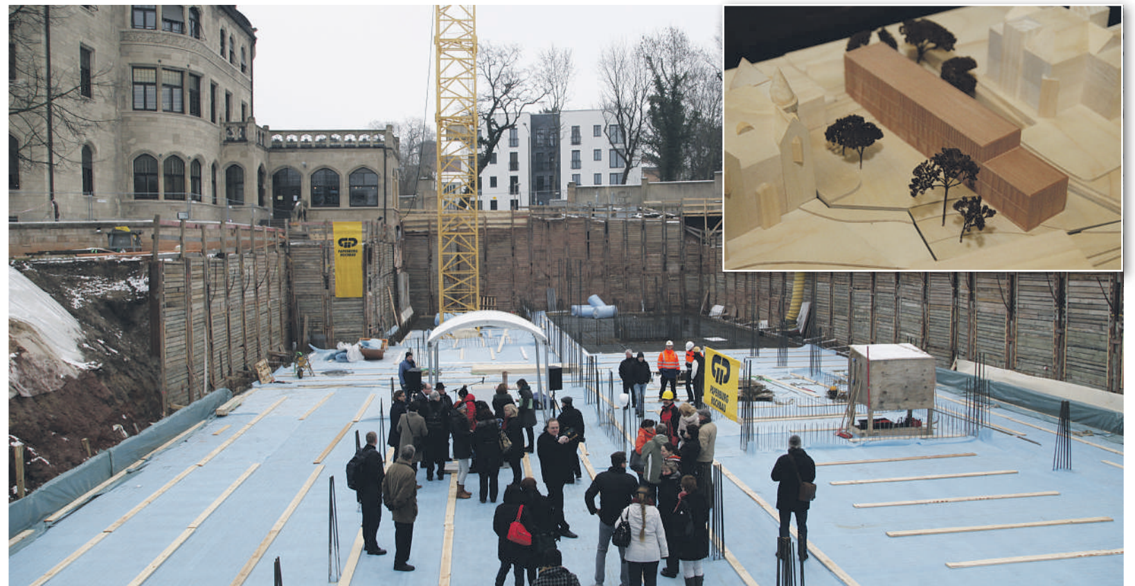
Eine Bibliothek entsteht neben der Burg-Villa am Neuwerk. Umgesetzt wird der Siegerentwurf (Modellfoto oben rechts im Bild) eines internationalen Architektenwettbewerbs, den das Land Sachsen-Anhalt ausgelobt hatte. Das neue Gebäude soll zum Sommersemester 2014 fertiggestellt sein. Fotos: Thomas Ziegler
