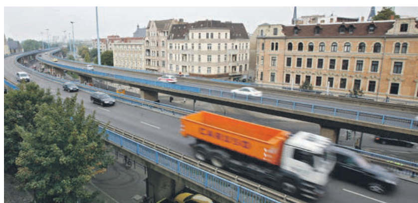
Im Zuge der Sanierung der Hochstraßen wird zunächst die südliche Brücke (im Bildvordergrund) gesperrt. Foto: Thomas Ziegler
