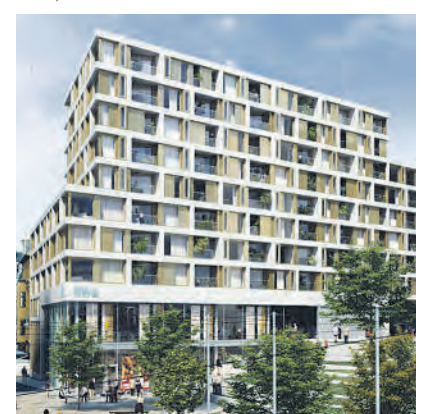
Am Riebeckplatz entsteht ein Wohn- und Geschäftshaus. Foto: HWG
