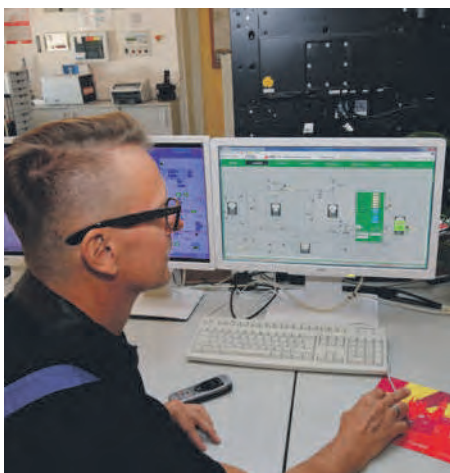
Mitarbeiter Mathias Todte startete in der Leitwarte des Energieparks per Mausclick die Pumpe: Mit der Wasserfüllung der Rohrleitungen beginnt der Probetrieb des Speichers.
