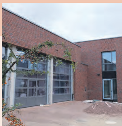
Fertigstellung: April 2020 Kosten: 2,5 Millionen Euro (100 % städtische Eigenmittel)
