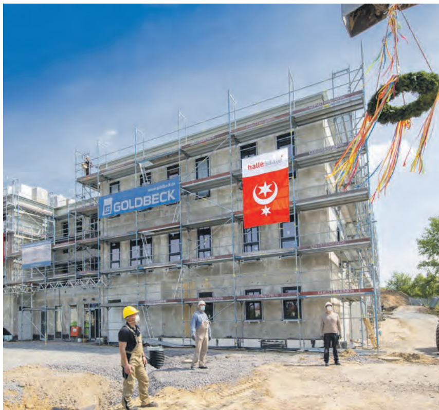
Der Richtkranz zeigt es an: Der Rohbau der Kindertagesstätte in der Albrecht-Dürer-Straße ist fertig. Foto: Thomas Ziegler
