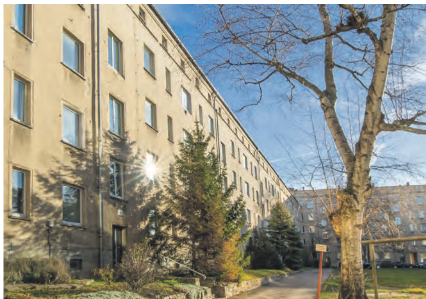
Die HWG saniert 2021 den Wohnkomplex Ernst-Toller-Straße 20.
