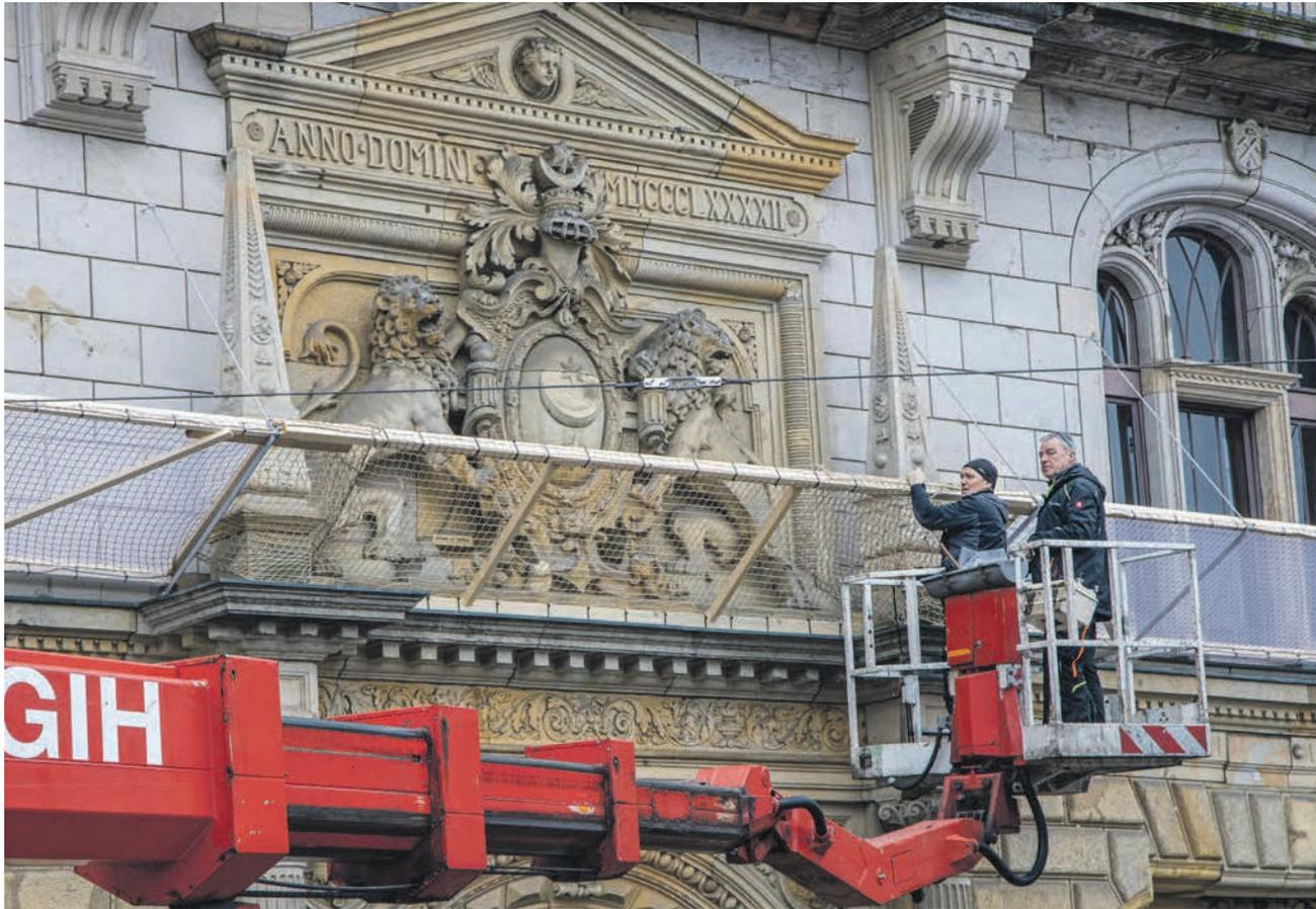
Die Fassade des Stadthauses soll Anfang Juli 2021 saniert werden. In Vorbereitung dazu hat die Stadt Halle (Saale) Anfang Februar Sicherungsarbeiten durchgeführt und Fanggitter im Rinnebereich der marktseitigen Dachfläche befestigt. Die Gitter verbleiben bis zur Reparatur der Dachflächen im Traufbereich. Die Sanierungsmaßnahmen wurden bereits ausgeschrieben, die Vergabe der Bauleistungen ist im April geplant.
