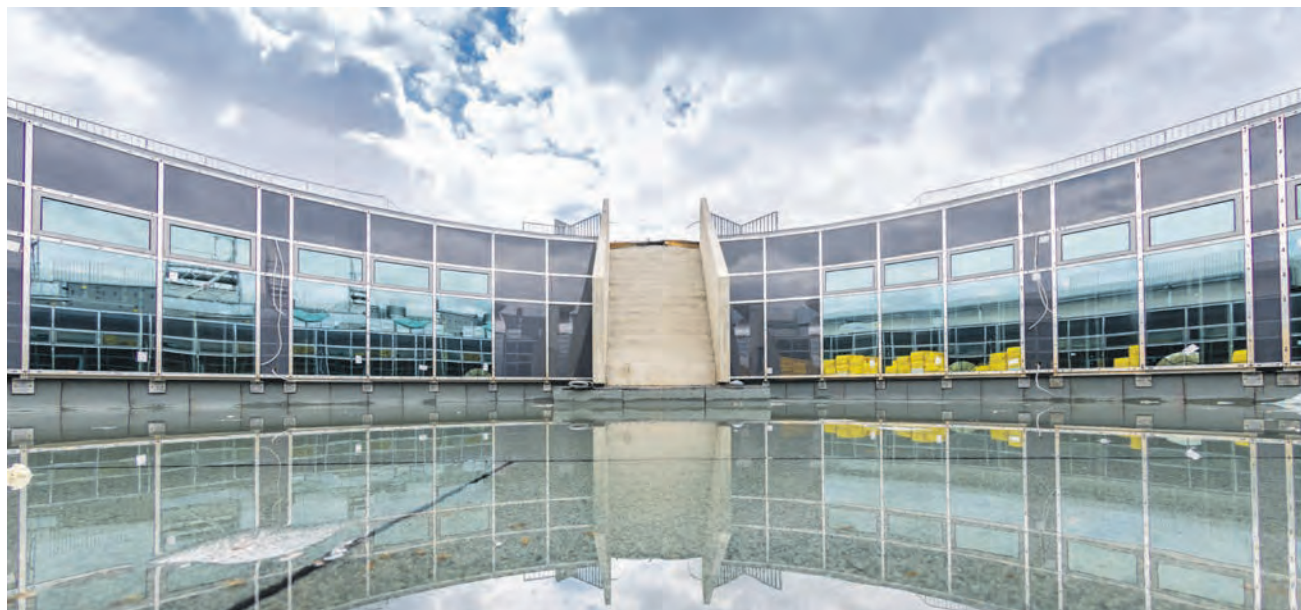
Im Planetarium auf dem Holzplatz erfolgt derzeit der Innenausbau. Die Außenterasse ist bereits verglast.
