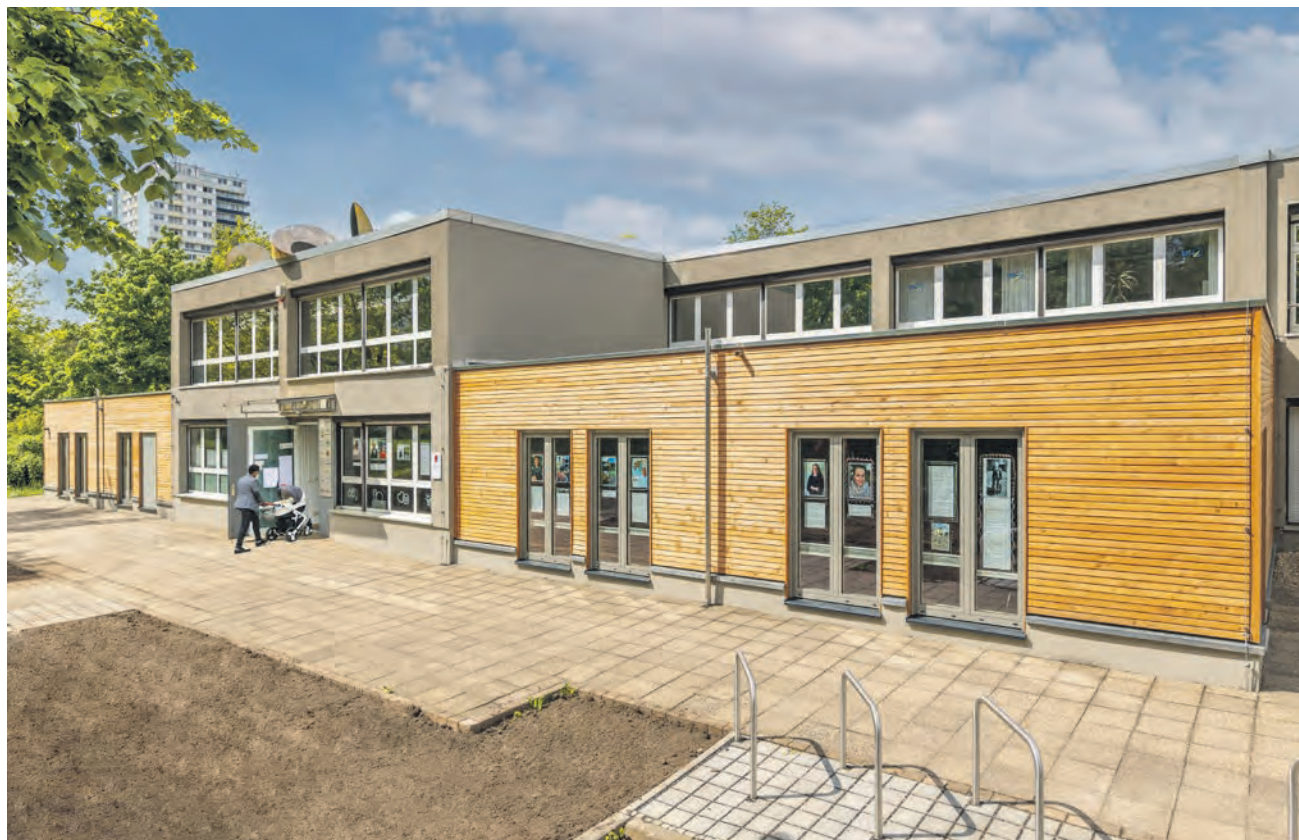
Das Mehrgenerationenhaus „Pusteblume“ wurde seit 2020 umgebaut. Nun sind die Arbeiten abgeschlossen. Foto: Thomas Ziegler
