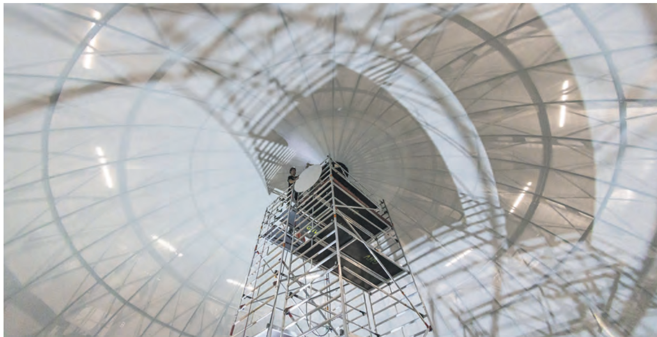
Lückenschluss im Planetarium: Am 2. August wurde das letzte Teilstück in die Sternenkuppel im Planetarium auf dem Holzplatz eingesetzt. Der Sternenhimmel besteht aus 144 dünnen Aluminium-Segmenten, die in den USA produziert wurden. Foto: Thomas Ziegler
