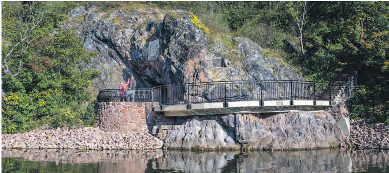
Das Rondell am Zugang zur Jahnhöhle kann nach der Sanierung wieder betreten werden.
