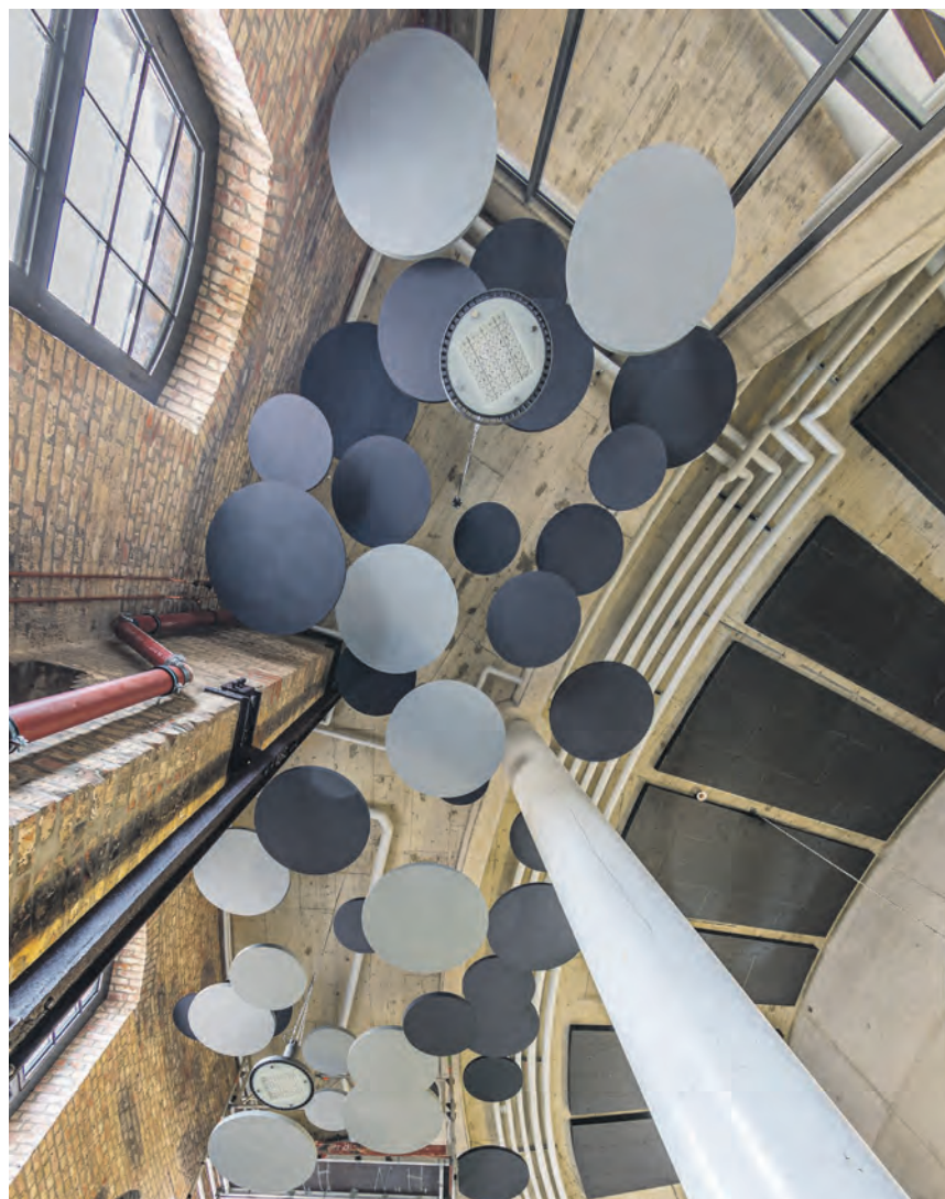
Im Planetarium schreiten die Arbeiten voran. Derzeit werden an der Decke im Eingangsbereich Akustik-Paneele montiert. Foto: Thomas Ziegler
