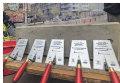
Mit einer Grundsteinlegung ist das Neubau-Vorhaben am Reileck offiziell gestartet. Foto: Thomas Ziegler
