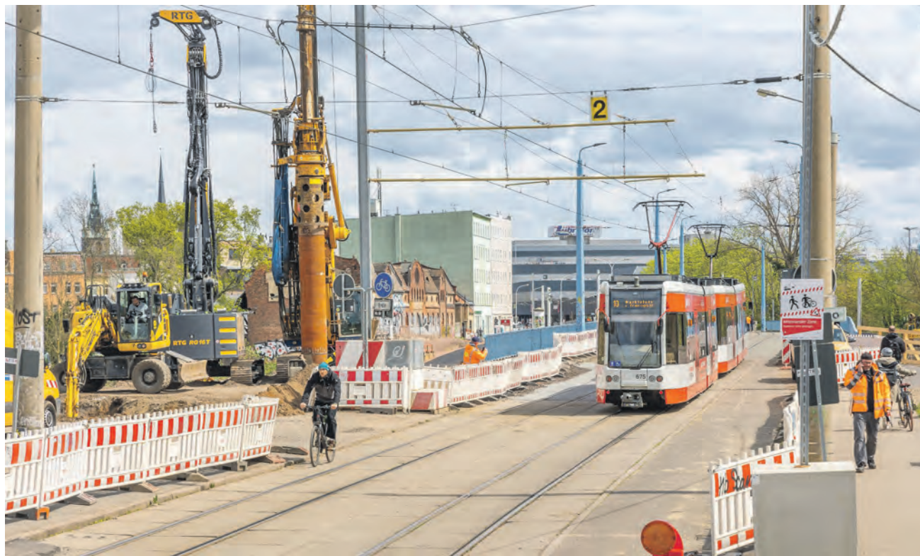
Der Ausbau der Mansfelder Straße umfasst auch den Neubau der Elisabethbrücke über die Saale.
