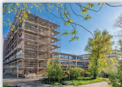
Das H-förmige Gebäude aus dem Jahre 1982/83 entspricht dem Typ „Erfurt 69“.
