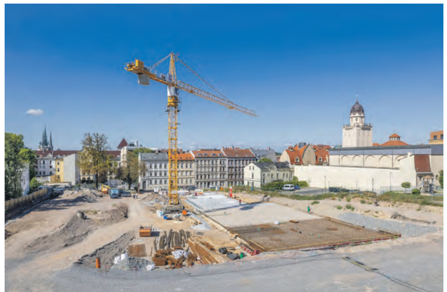
Blick auf das Baufeld in der Schimmelstraße
