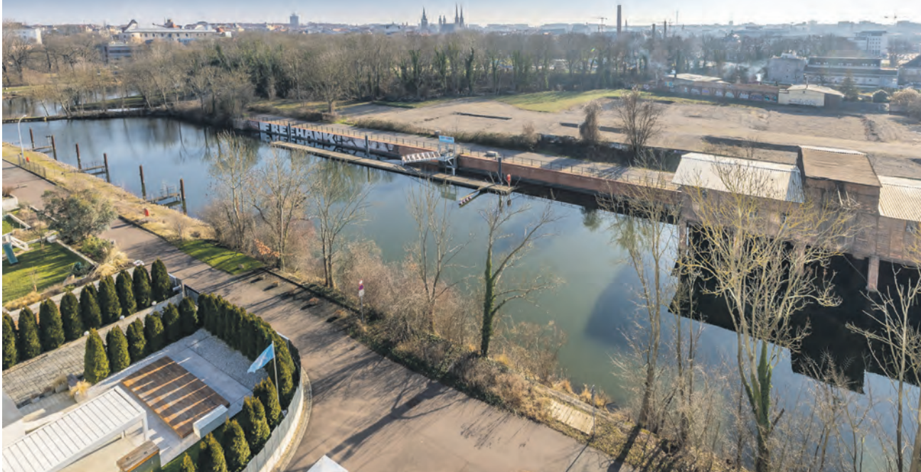
Am Sophienhafen sollen auf der Freifläche weitere Wohngebäude entstehen.
