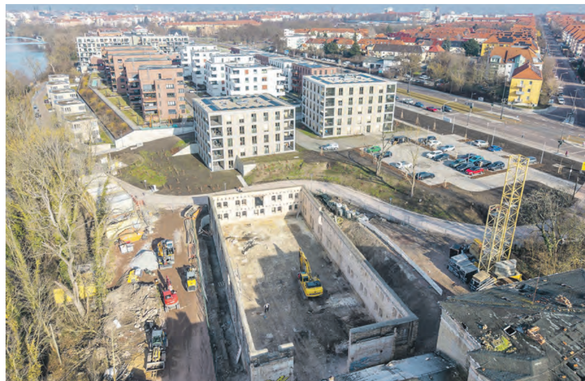
Die GWG hat bereits mit dem Umbau des Speichers der ehemaligen Böllberger Mühle begonnen.
