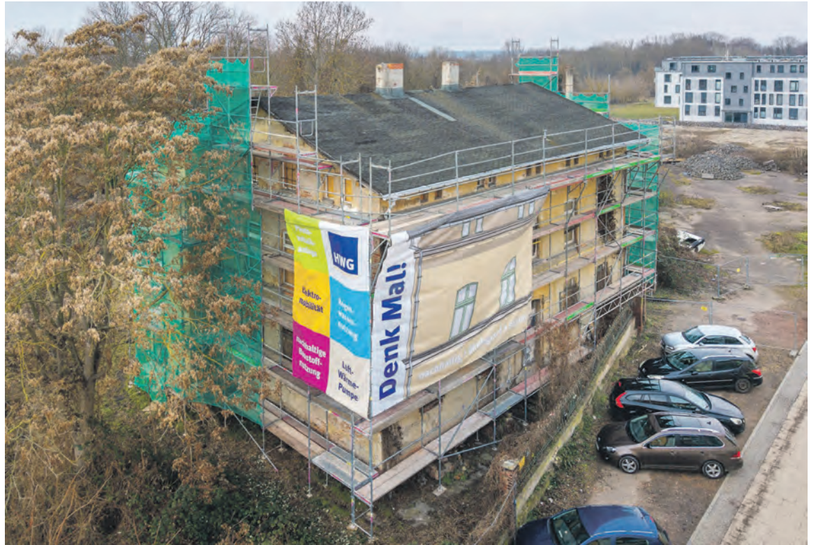
Im Juni will die HWG mit der Sanierung des Denkmals in der Hafenstraße 7 beginnen.
