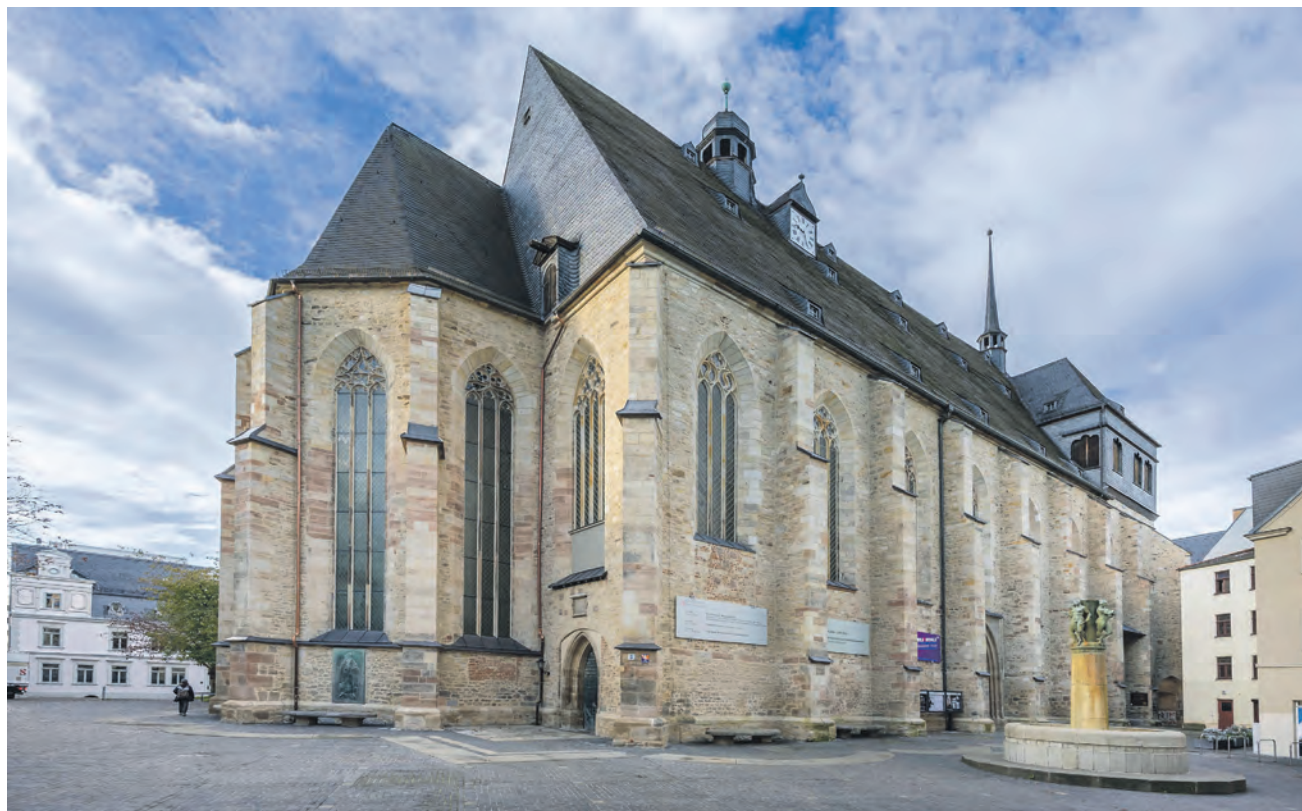
Im September vergangenen Jahres konnte die Sanierung der Konzerthalle Ulrichskirche abgeschlossen werden. Im letzten Bauabschnitt wurden Nord- und Ostfassade denkmalgerecht saniert.
