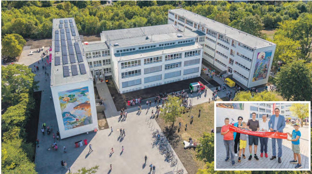
Gemeinsamer Banddurchschnitt nach erfolgreicher Sanierung (v.l.): Annette Winkler (Leiterin der Grundschule), Danilo Halle (Künstler von der Freiraumgalerie und Gestalter der beiden Wandbilder), Katharina Brederlow (Beigeordnete für Bildung und Soziales) und Oberbürgermeister Dr. Alexander Vogt
