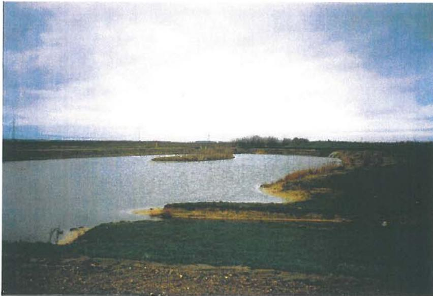
Abb. 4: Durchfluß des Dölbauer Grabens durch den Regenwasserrückhalteteich des Industriegebietes Queis (Foto).
