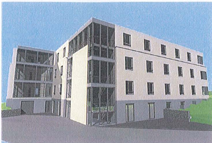
Blick von Süd-Osten
