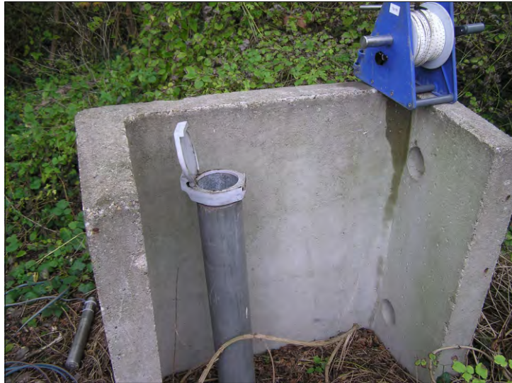
Foto 10 - Blick nach Nordost auf GWM 2006/93 (19.10.2020)
