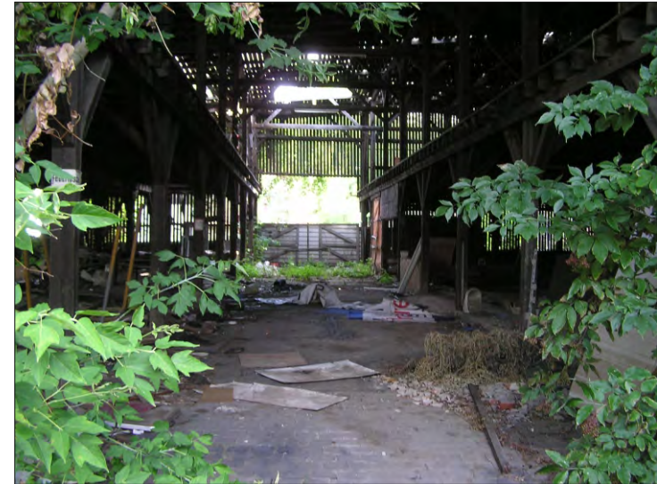
Foto 7 - Blick nach Osten in Lagerhalle der VF 2 (25.08.2020)
