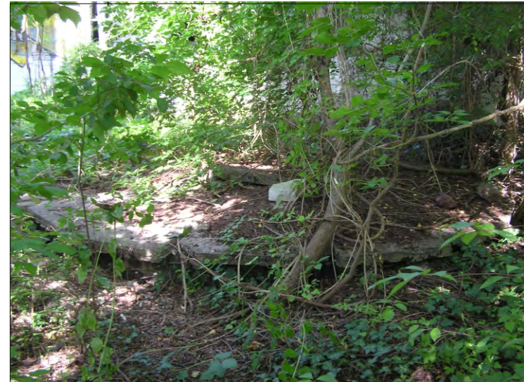
Foto 9 - Blick nach NW auf Klärgrube hinter Rockstation (25.08.2020)
