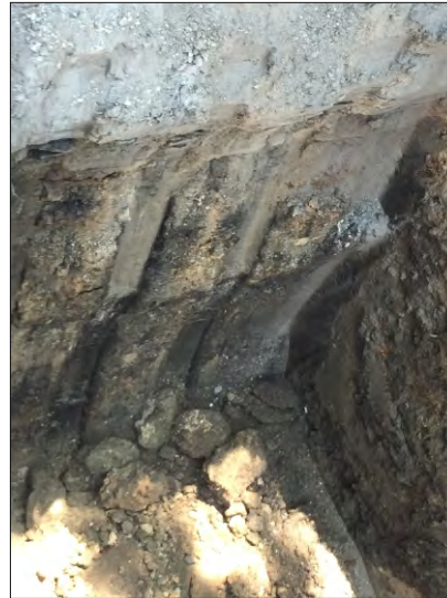
Foto 2 - Blick nach Nord in Schurf im vermuteten Tankbereich: kein Tank, dunkel verfärbtes Erdreich (25.08.2020)
