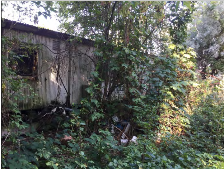
Foto 1 - Blick nach NW auf Baracke (VF 3, 09/20 abgebrannt) (25.08.2020)
