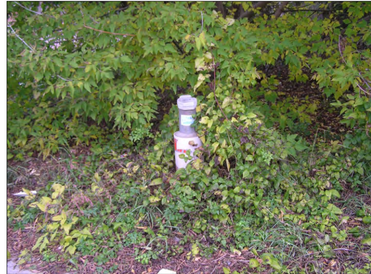
Foto 11 - Blick nach Ost auf GWM 2007/93 (19.10.2020)
