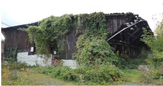
7. Außenansicht G 7, Westseite
