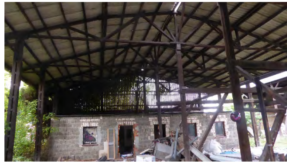
8a. Dach und Ostseite des Anbaus (G 8)
