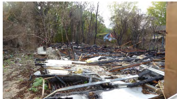
11b. Außenansicht, Nordseite
