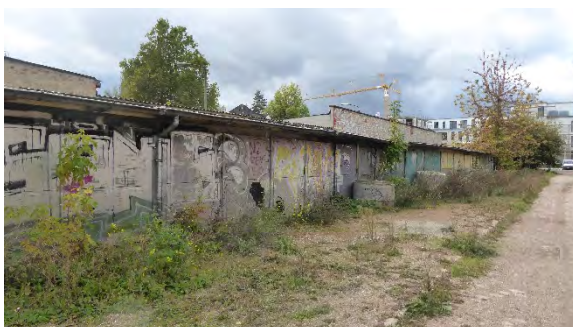
5a. Außenansicht, Nordseite
