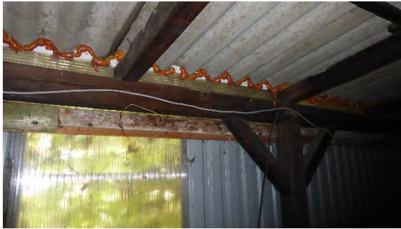
2c. versiegelte Öffnungen am Dach (innen)
