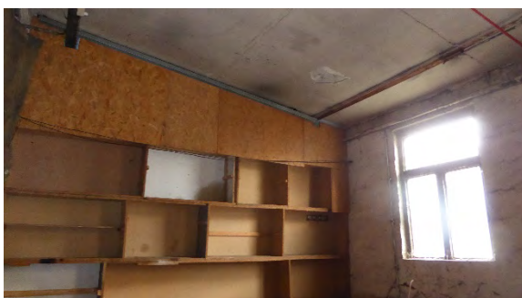
5c. Nebenraum mit eingebautem Holzregal
