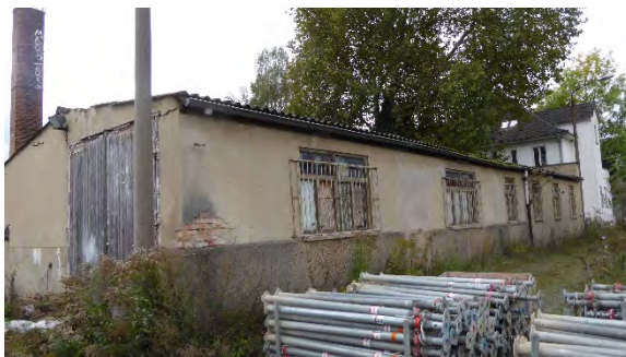
5a. Außenansicht, Nordseite
