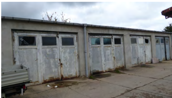
3a. Außenansicht (Nordseite)
