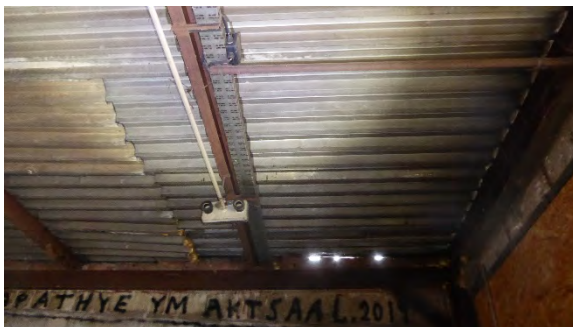
13c. Flachdach im westlichen Teil
