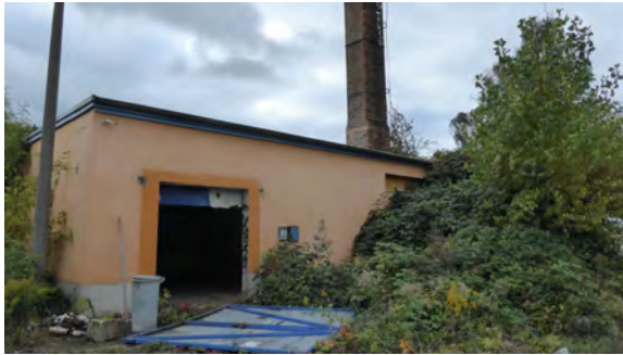
6a. Außenansicht, Nordseite
