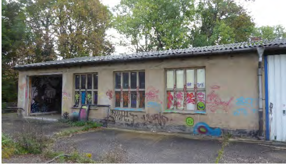
5a. Außenansicht, Nordseite
