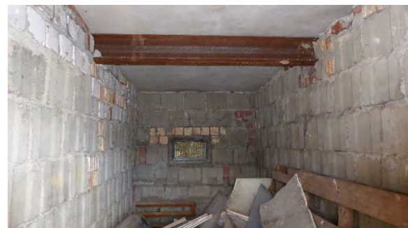
13f. Innenansicht des Anbaus
