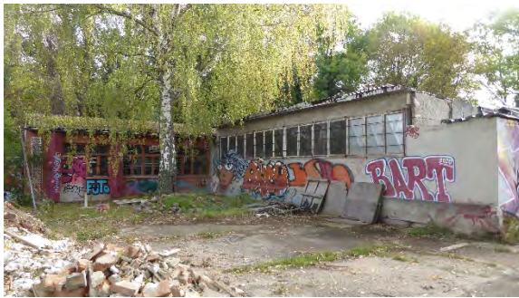
13a. Außenansicht, Nordseite
