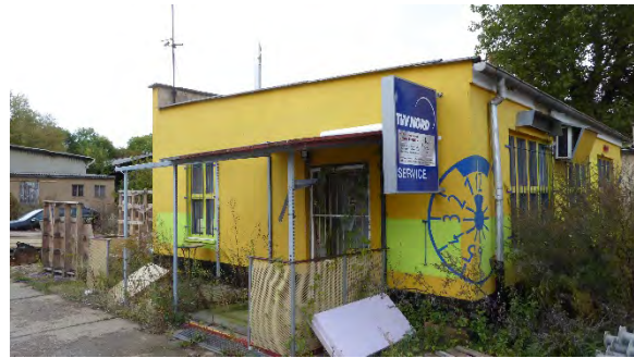
4b. Außenansicht, Nordseite
