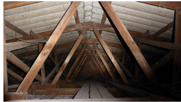
13b. Dachgeschoss im östlichen Teil
