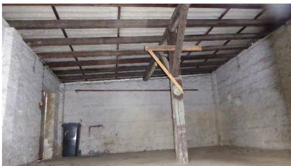
9a. Innenansicht südlicher Anbau (G 9)
