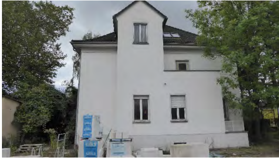
1a. Außenansicht, Nordseite
