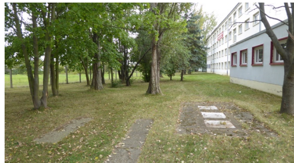
Gebäude mit Baumbestand
