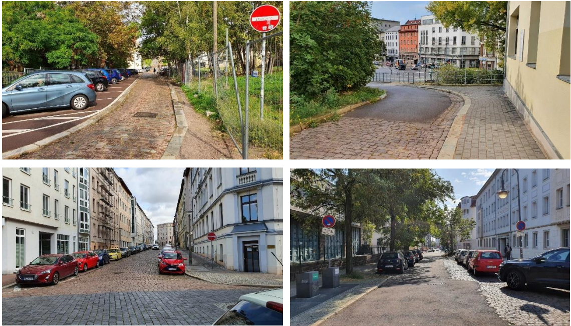
Fotos: Verkehrliche Defizite – schmale, unbefestigte Gehwege (oben links), enge Radien am Töpferplan (oben rechts), StVO-widriges Parken (unten links), sanierungsbedürftige Straßen (unten rechts)
