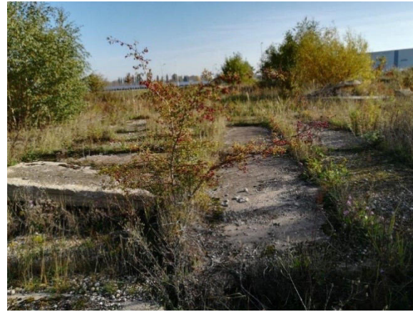
Abbildung 8: Häufiges Bild im Plangebiet; Betonbodenplatten mit Ritzen und emporkommender Vegetation (Foto: Büro Schulz UmweltPlanung, 15.10.2019)
