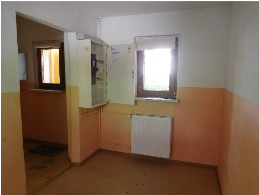
Nebenraum, nordöstlicher Eingangsbereich/Anbau
