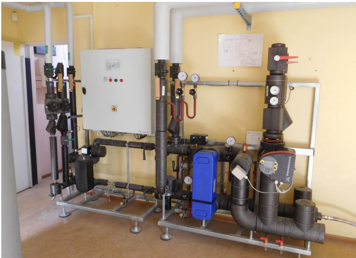
Fernwärme-Kompaktstation
