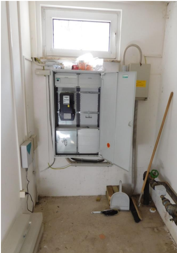
Sicherungen und Stromzähler
