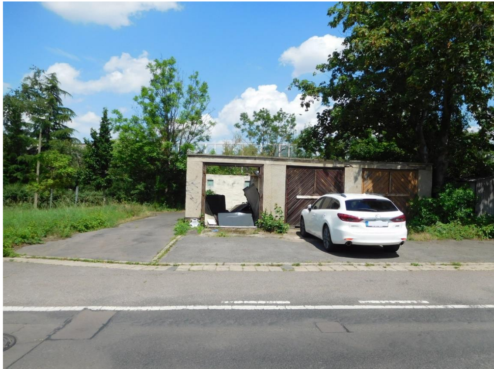
Teilansicht von Süden
