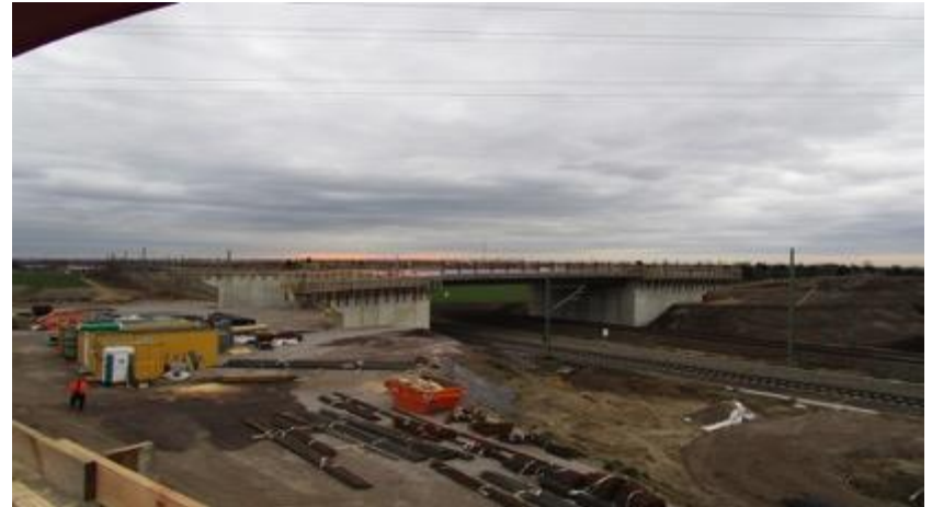
Brücke über das DB Gleis Halle-Berlin
