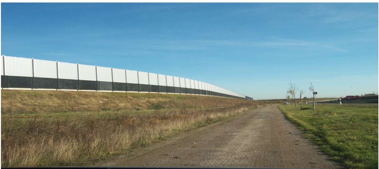
Abb. 19 Lärmschutzwand (Quelle: FLHG)
