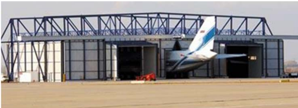
Abb. 26 Triebwerksprobelaufhalle (Quelle: FLHG)
