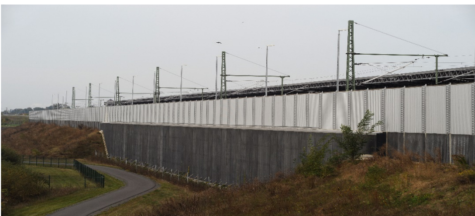
Abb. 27 Lärmschutzwand (Quelle: FLHG)
