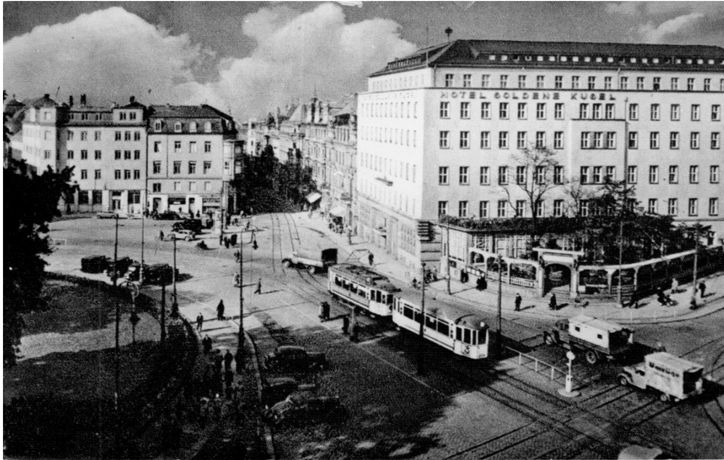
Hotel Goldene Kugel: Um- und Erweiterungsbau ca. 1925 - Architekt Hermann Frede
