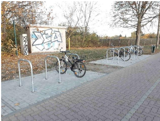
Fahrradbügel an der Straßenbahn-Endstelle Elsa-Brändström-Straße
