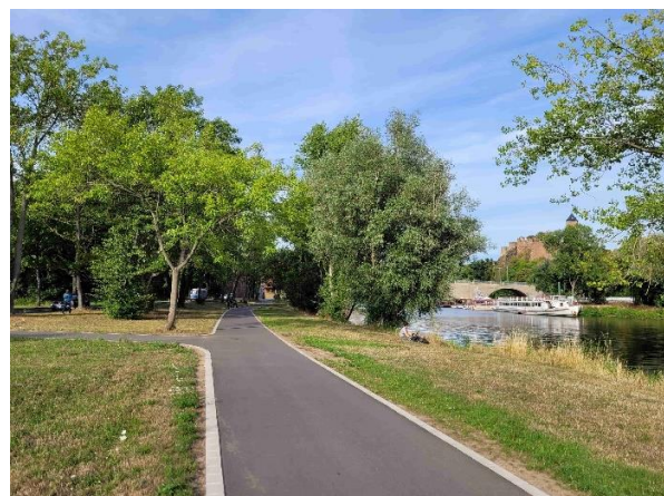
Weg entlang der Saale im Bereich Talstraße
