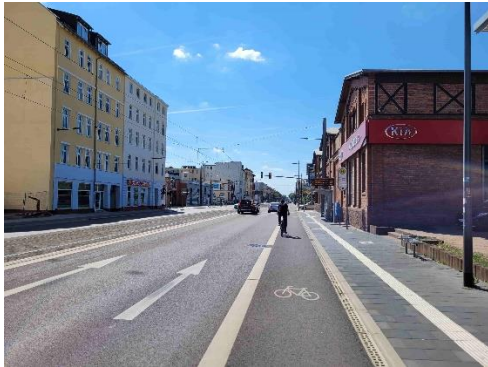
Radverkehrsanlage in der Merseburger Straße
