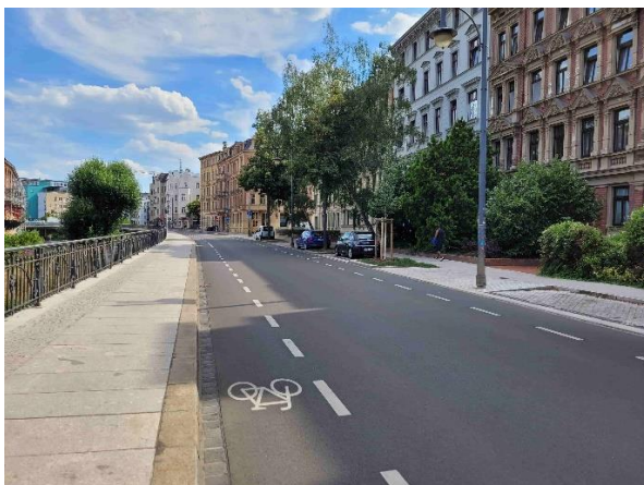
Robert-Franz-Ring nach dem Umbau
