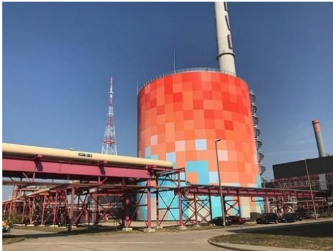
Abbildung 30: Neuer Energiespeicher in der Stadt Halle (Saale)
