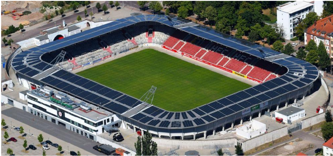
Abbildung 21: Photovoltaik-Solaranlage am Stadion
